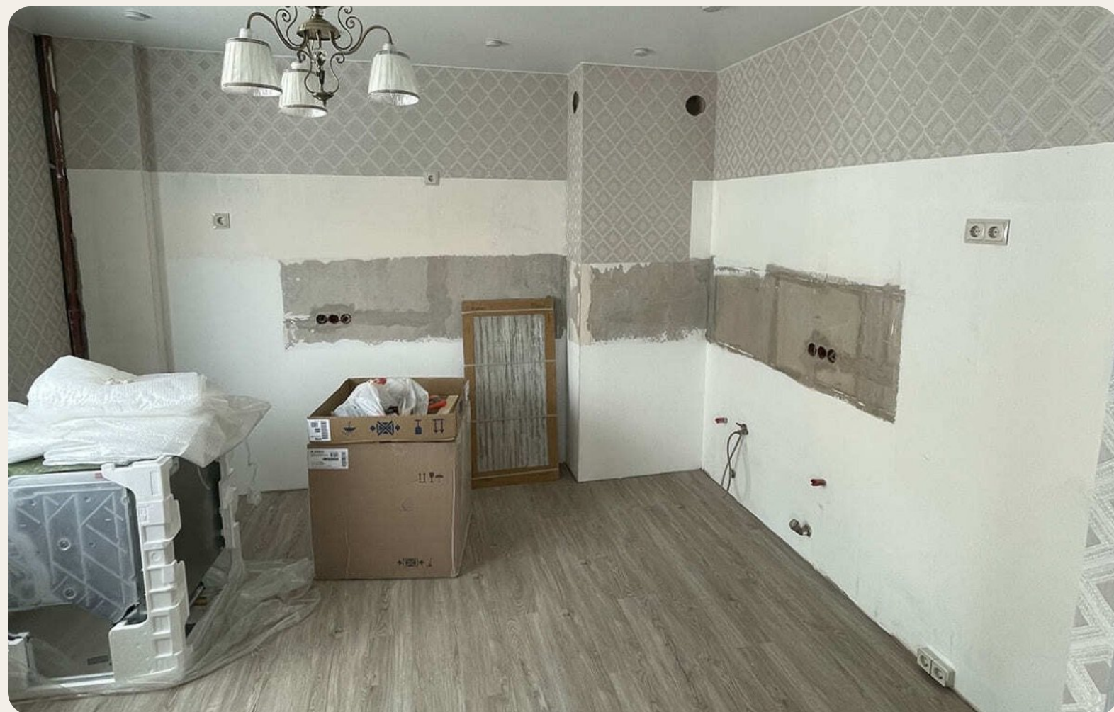
Комната после демонтажа
